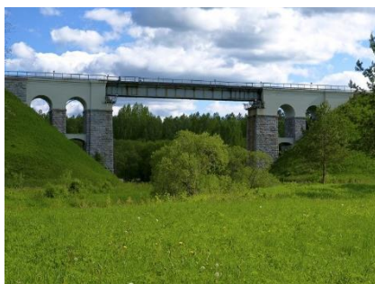
B Dzelzceļa tilts pār Raunu
